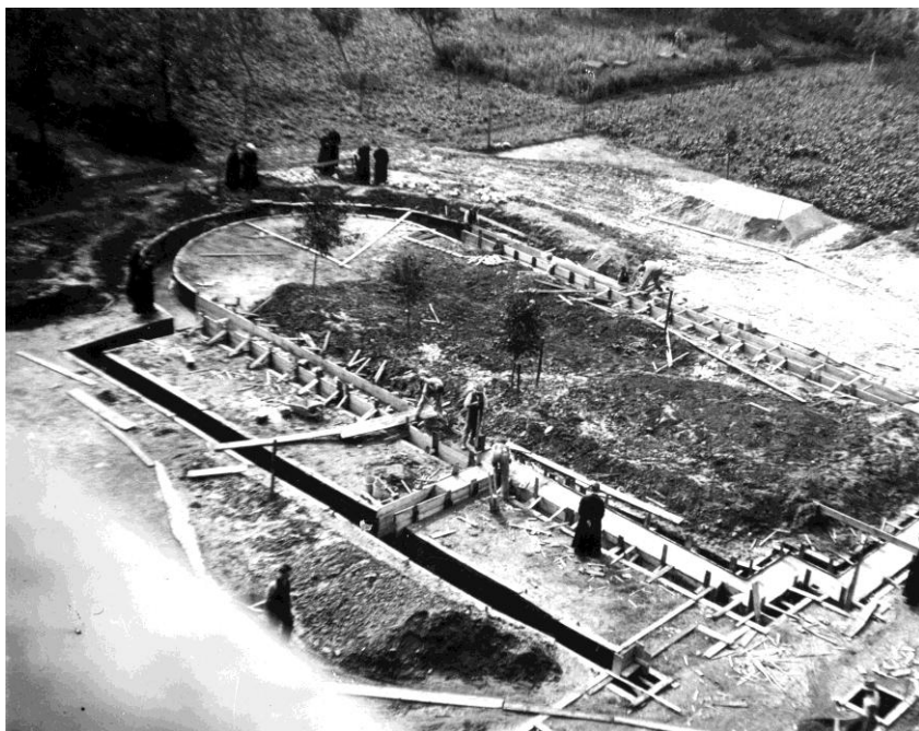
Zakładanie fundamentów betonowych
