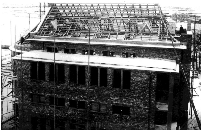
Finalizowanie budowy budynku – budowa dachu
